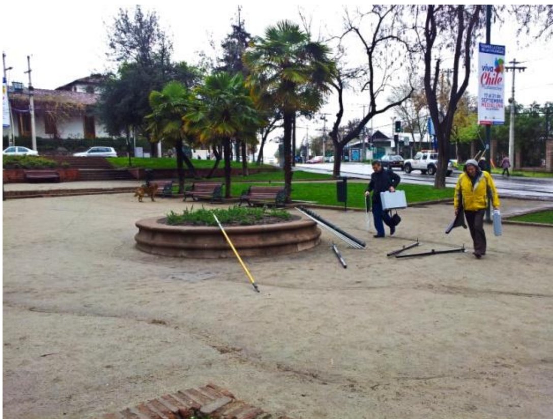
Figura 5.- Instalando el equipamiento
