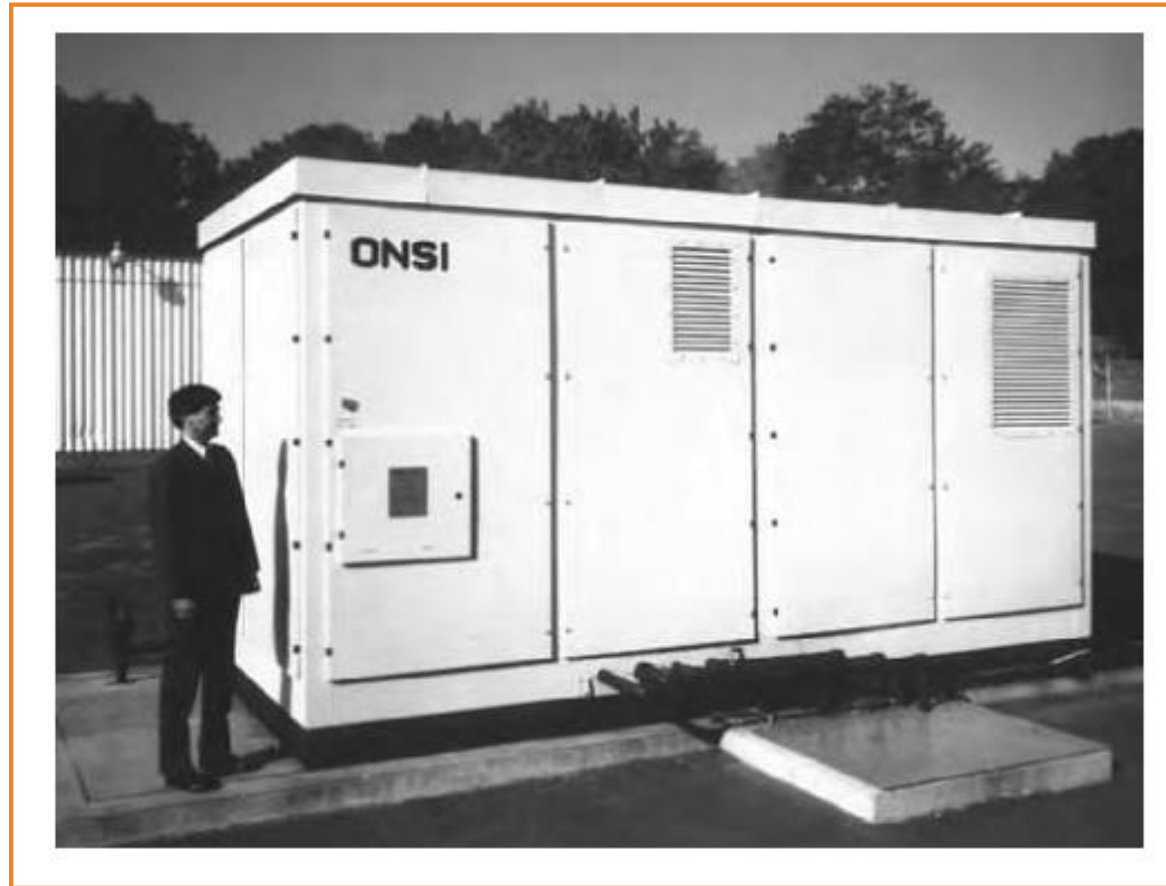
Figura 4. Celda de combustible de ácido fosfórico. Genera 200 kW de electricidad y cerca de 200 kW de energía térmica (vapor). Estas unidades son conocidas como sistemas combinados de generación de calor y potencia (CCCP) .
