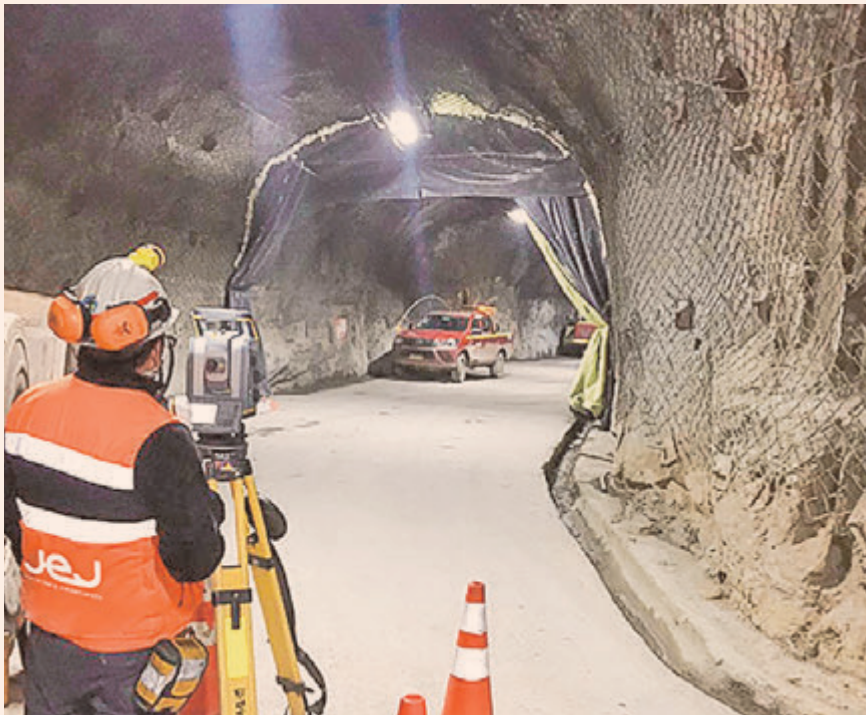
J.E.J. desempeñó un papel crucial en la participación de la construcción de la Rampa Conectividad en División Andina, un hito que a través de un túnel unió la mina subterránea y la mina rajo.
